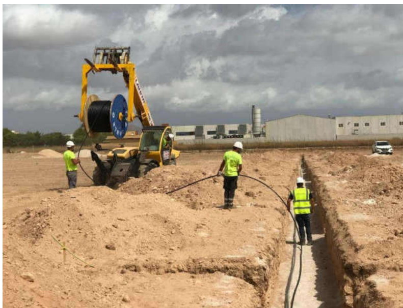
Útil de tendido mediante manipulador tipo 2.
